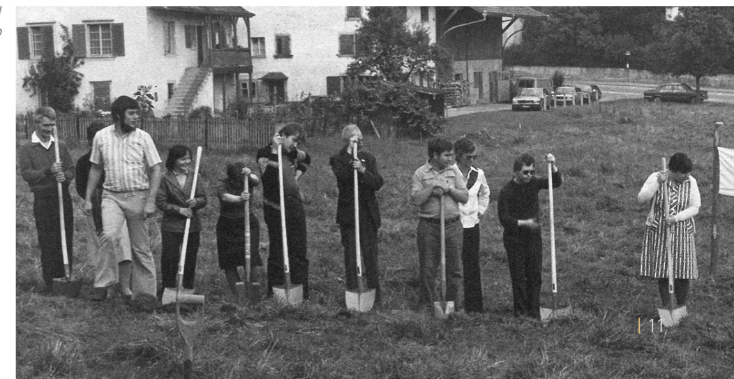
Werkheim Uster ZH Spatenstich 1979
